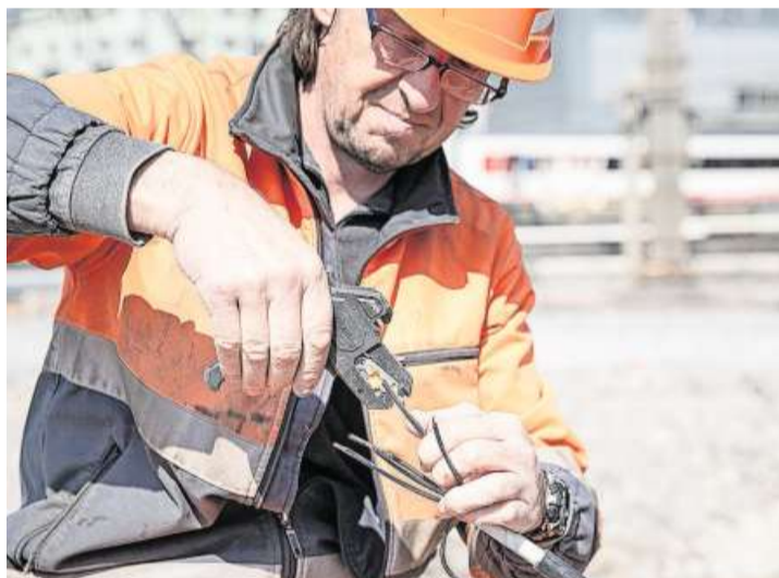
Auf der grossen Baustelle am Bahnhof Luzern werden wegen der Doppelspur – aber nicht nur – vier Kilometer Gleise rückgebaut, 2,3 Kilometer Gleise komplett ersetzt und Dutzende Weichen angepasst. Auch neue Kabel- und Stromleitungen sind nötig.
